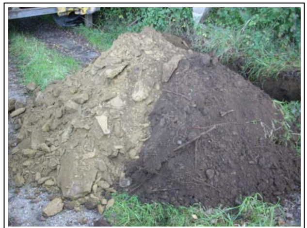
Calicata C-6 y material extraído
