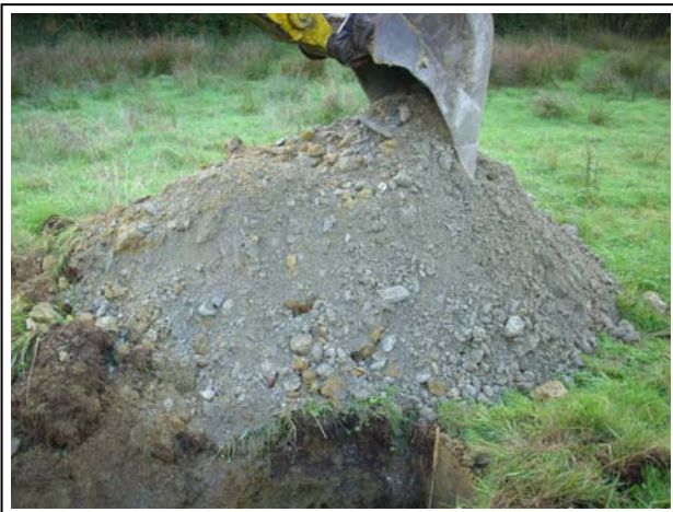
Calicata C-20 y material extraído
