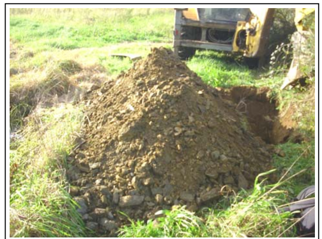
Calicata C-3 y material extraído
