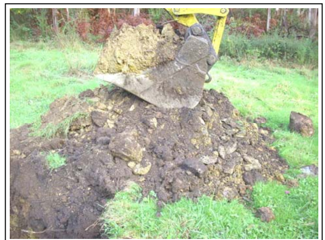
Calicata C-18 y material extraído
