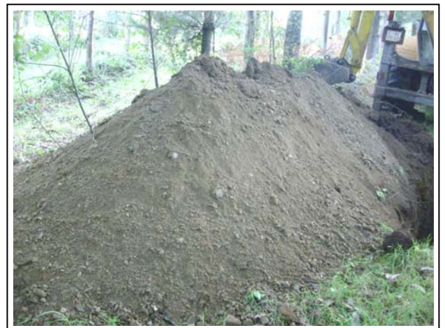
Calicata C-12 y material extraído
