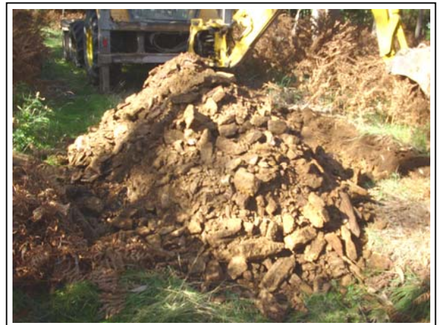
Calicata C-9 y material extraído
