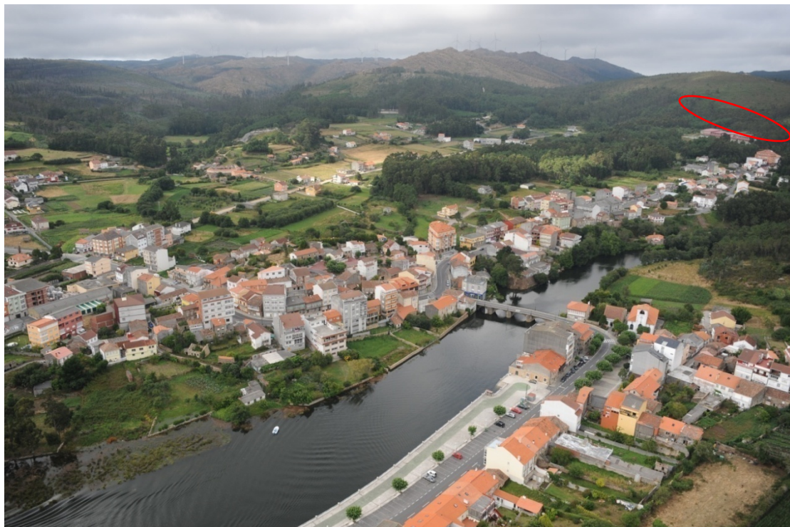
Foto 28: Fondo de la Ría do Porto y núcleo de Ponte do Porto. Al fondo de la imagen, en la esquina superior derecha se localizará el Parque Empresarial. Fuente: POL.
